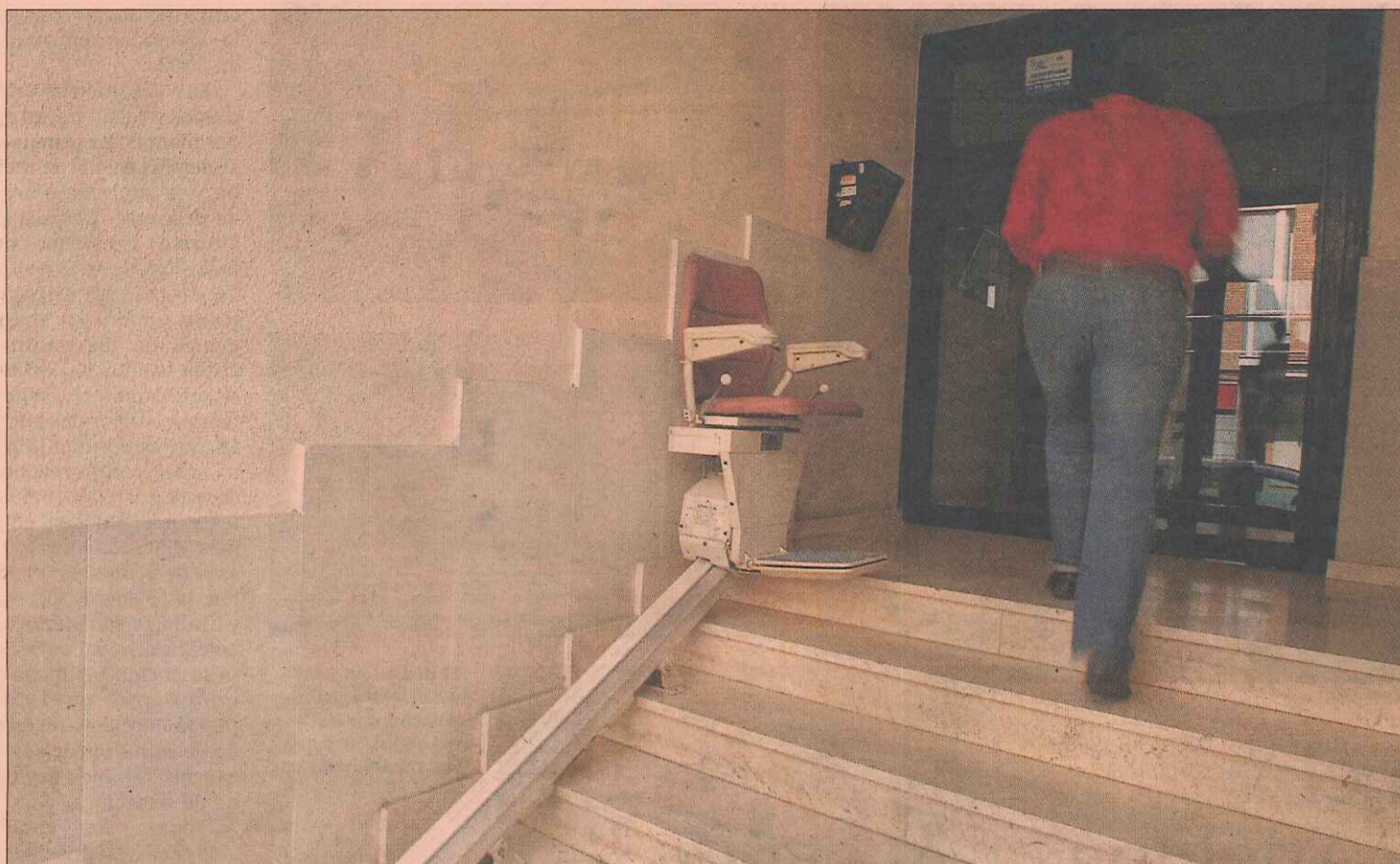
Silla mecánica para salvar las escaleras instalada en el acceso a una finca en Madrid. / LUIS SEVILLANO
